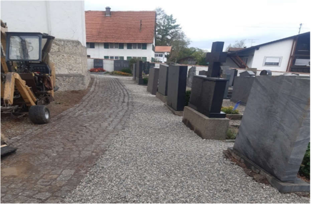
Beseitigen der Tuja Hecke auf dem Friedhof und Ausbesserung der gepflasterten Wege
