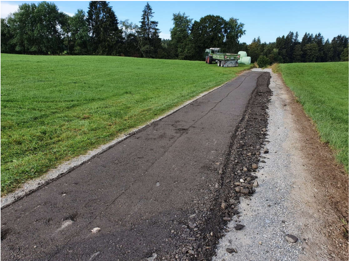
Wegebau mit der Wegepflegemaschine (gemeinschaftliche Nutzung mit der Gemeinde Oy-Mittelberg)
